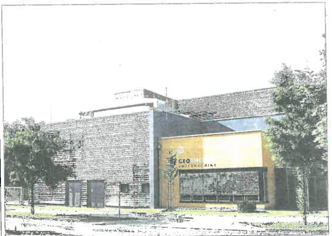
Fast schon ein Wahrzeichen! Am Grünwalder Weg in Unterhaching ist die Geothermie-Anlage zu finden. Foto: Geothermie Unterhaching
