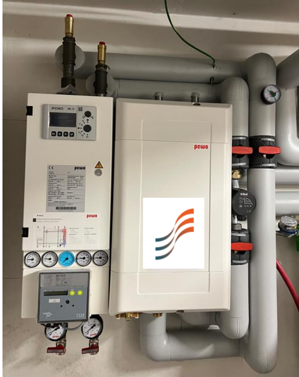
Unterstation mit eigenem Regler und Wärmemengenzähler
