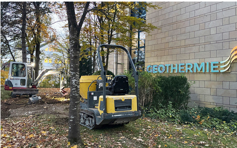
Bauarbeiten zur Verlegung des Hausanschlusses für die Witneystraße 1.
